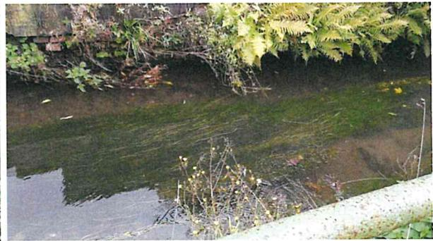
Partiell kommt es im Bereich unterhalb des Sportplatzes und nördlich der Brücke Friedrich-Neumeyer- Str. zu Einengungen des Abflussprofils durch Gehölze. Diese Einengungen müssen durch den GUV beseitigt werden.
